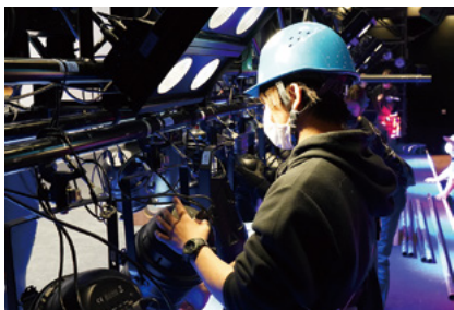
▲配線に気を配りながら、灯体を1つずつ取り付けます
